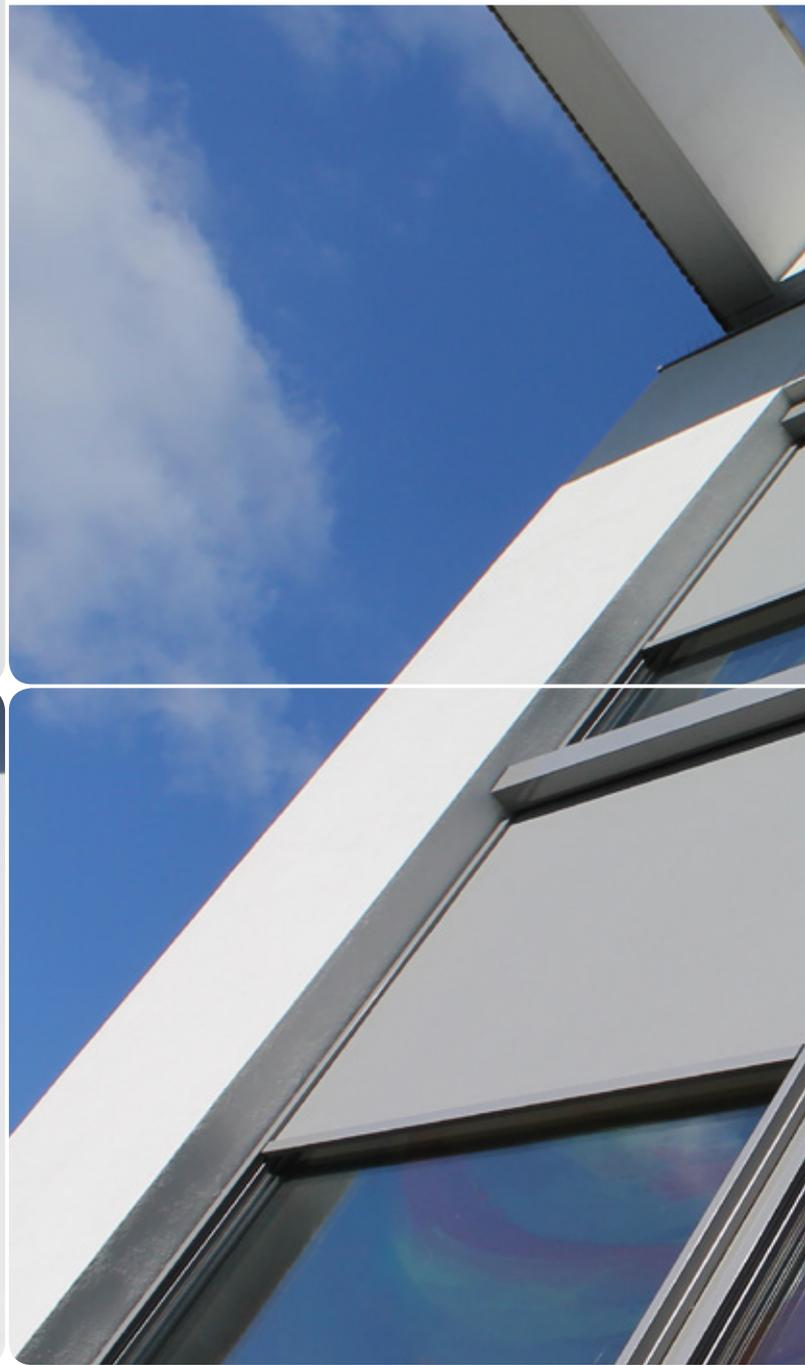
Das Hauptmerkmal des SolidScreen XL ist - wie sein Name schon sagt - die besondere Größe. Die besondere Konstruktion mit versteiften Materialien ermöglicht den Einsatz als Markise mit bis zu 6 Metern Breite bzw. Höhe.
